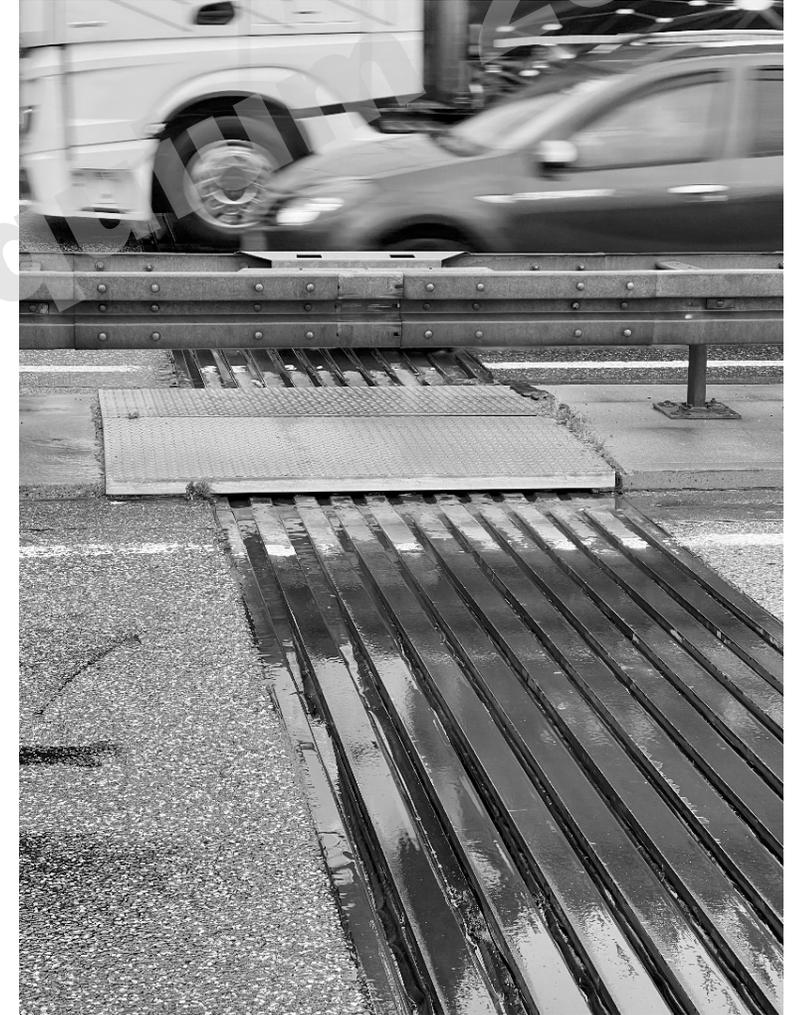
2002 eingebauter feuerverzinkter Fahrbahnübergang Talbrücke Reichenbach A71
